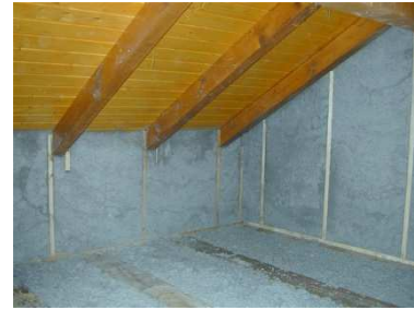
Projection humide d'isolant en ouate de cellulose
